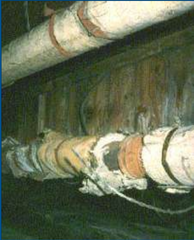
Izolatii pentru tevi si boilere, degradate
