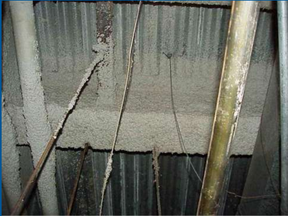
Material ignifug cu Az aplicat prin sprayere
